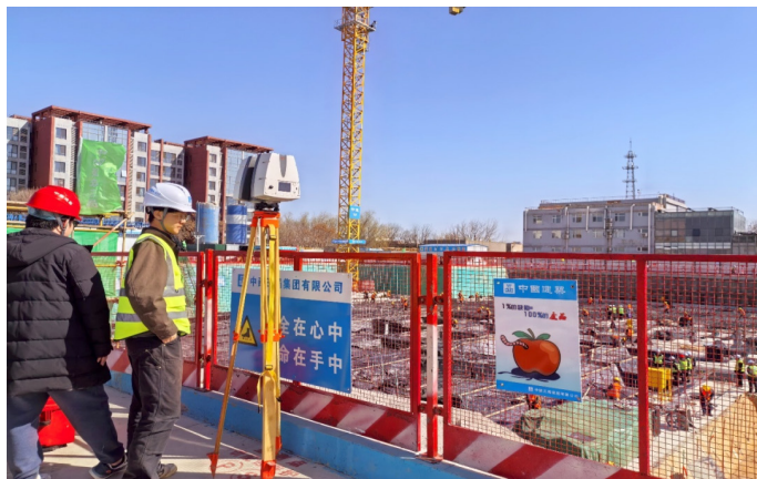
图4 北京建筑大学11号宿舍楼3D扫描工作
